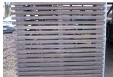
Eksempel på let konstruktion af stål og ubehandlet træ.
