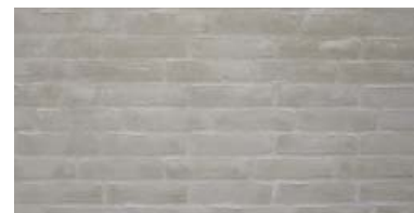
Eksempel på vandskuret mur, sandfarvet i en lys støvet tone
