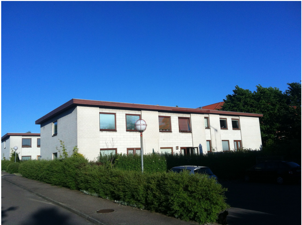
Figur 2. Den foreslåede bygningstype svarer til det moderne byggeri i Løvparken.
